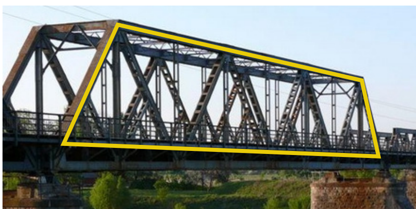
Dzelzceļa tilts Skrundā
